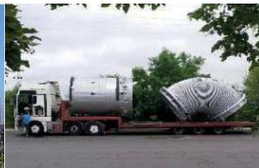
Система газоочистки. Новые газоходы
